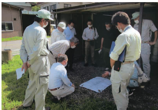
中条地区歩道設置工事現地調査 (県道歩道早期着工)
