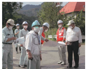
大岡地区地すべり防止対策現地調査(早期完成)
